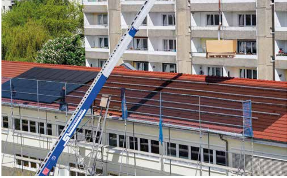
Blick auf die Montagearbeiten: Die ersten Module sind montiert, die spätere Gesamtfläche ist auf dem Foto dunkel dargestellt.
